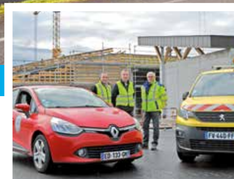
« Rouges » et « jaunes » sur le chantier de construction.
