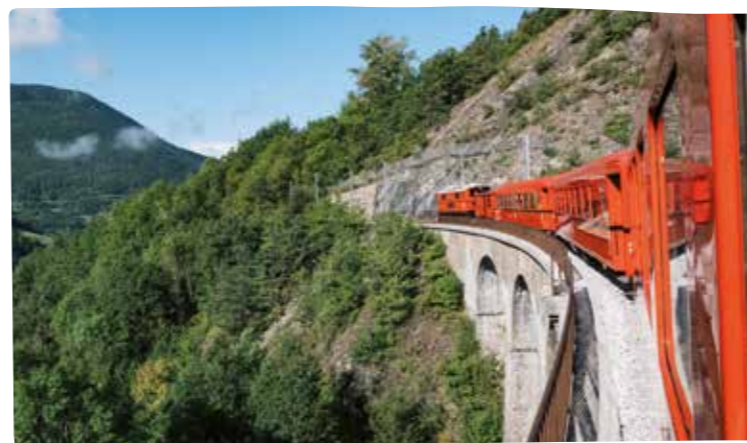
Le viaduc du Villaret
