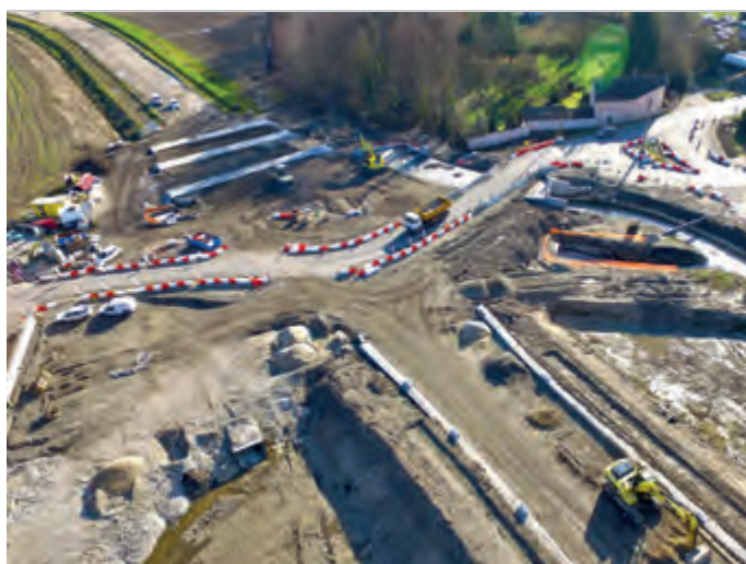
Vue aérienne d'un des giratoires de la déviation d'Aoste. Cette opération a nécessité trois ans de chantier et coûté 9,4 millions d'euros.
