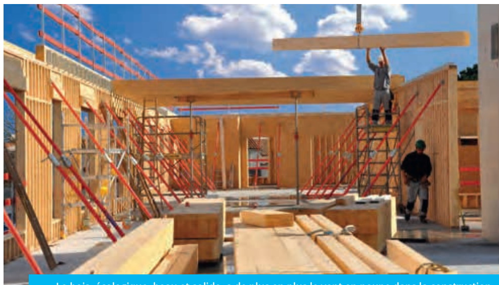
Le bois, écologique, beau et solide, a de plus en plus le vent en poupe dans la construction.
