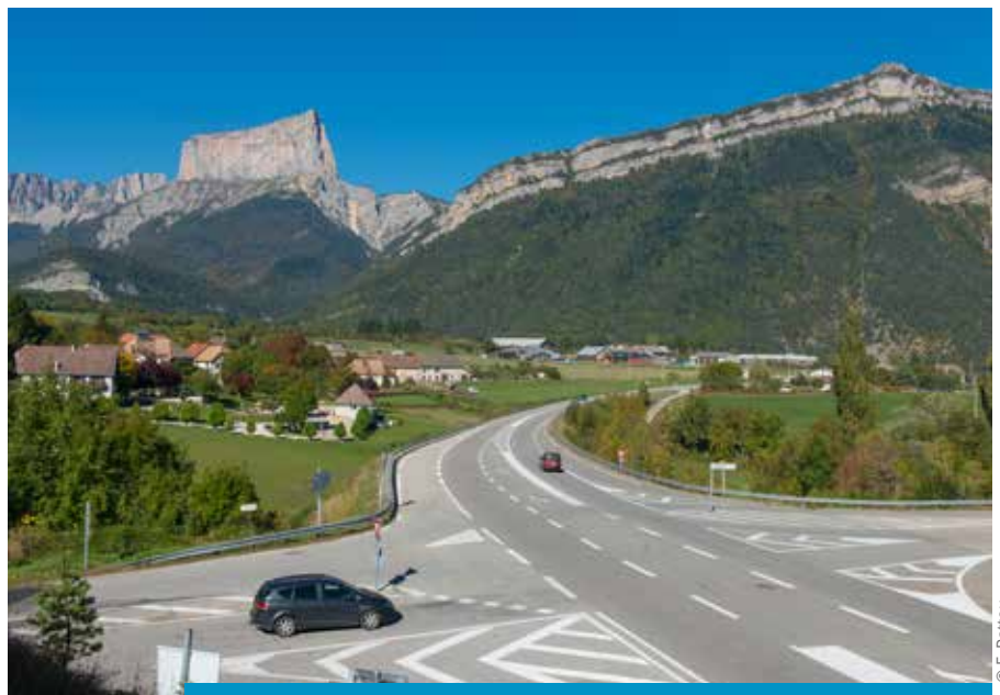
La RD 1075, qui irrigue toutes les communes du Trièves, va être rénovée.
